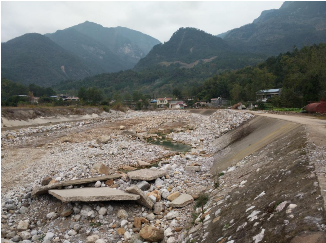
图 3-3 白鹤桥上游堤防现状照片
